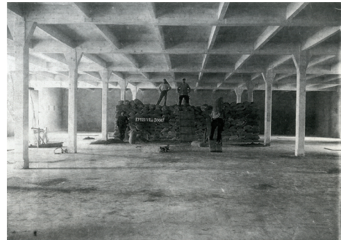
Entrepôt à Nantes, Loire-Atlantique, 1902-03, Clériceau et Tessiers architectes, Ducos entrepreneur, épreuve de réception.
