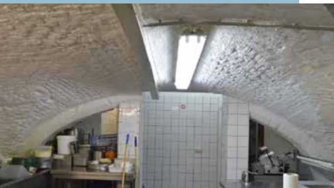
Maison du Paon, Grand-Place 35, les caves datées vraisemblablement du 15 e siècle (© BUP-DMS/ULB).
